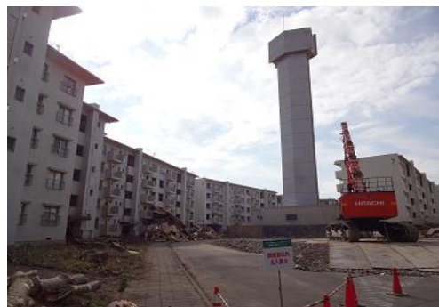
既存建物解体直前の団地内
