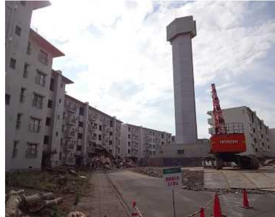
既存建物解体直前の団地内
