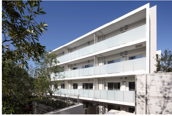
敷地南東側からの現建物外観
